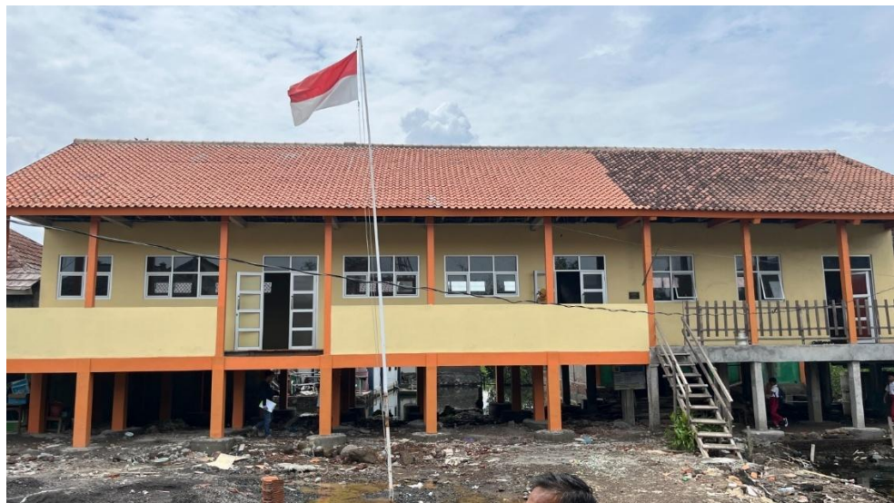
Dokumentasi Foto Sesudah di Rehabilitasi Ruang Kelas
