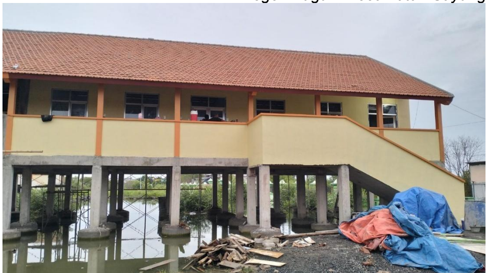
Dokumentasi Foto Sesudah Pembangunan Ruang Kelas Baru di SD Negeri Tugu 2 Kecamatan Sayung
