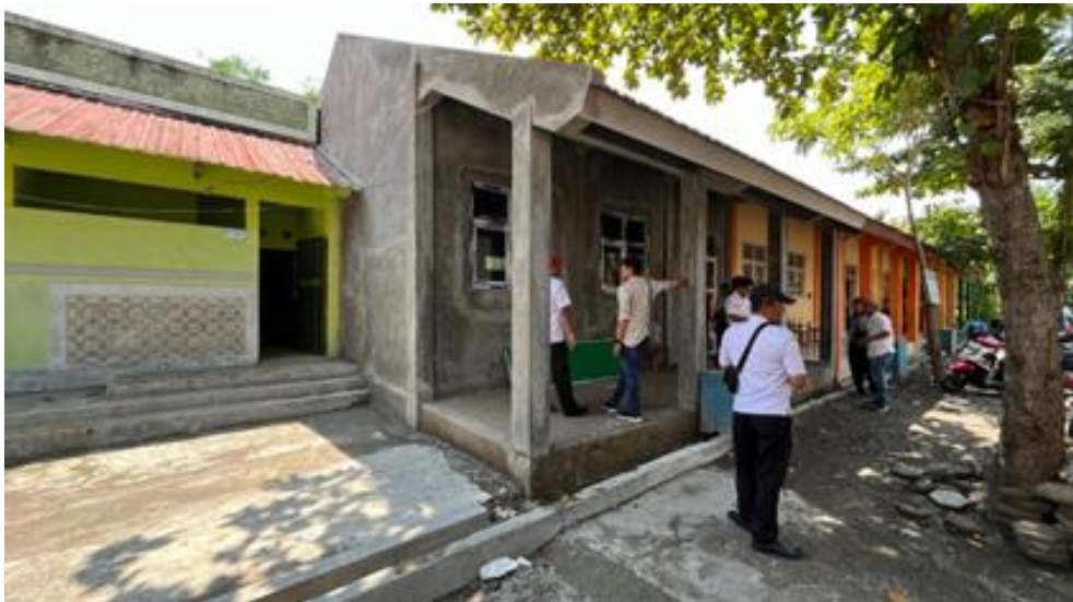
Dokumentasi Foto Sesudah Pembangunan Ruang Kelas Baru
