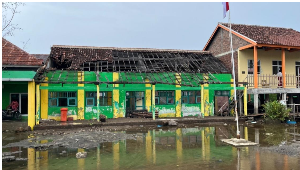
Dokumentasi Foto Sebelum di Rehabilitasi Ruang Kelas
