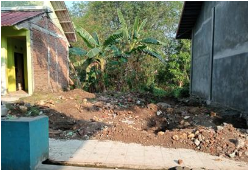
Dokumentasi Foto Sebelum Pembangunan Ruang Kelas Baru
